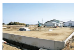
造成工事現場
